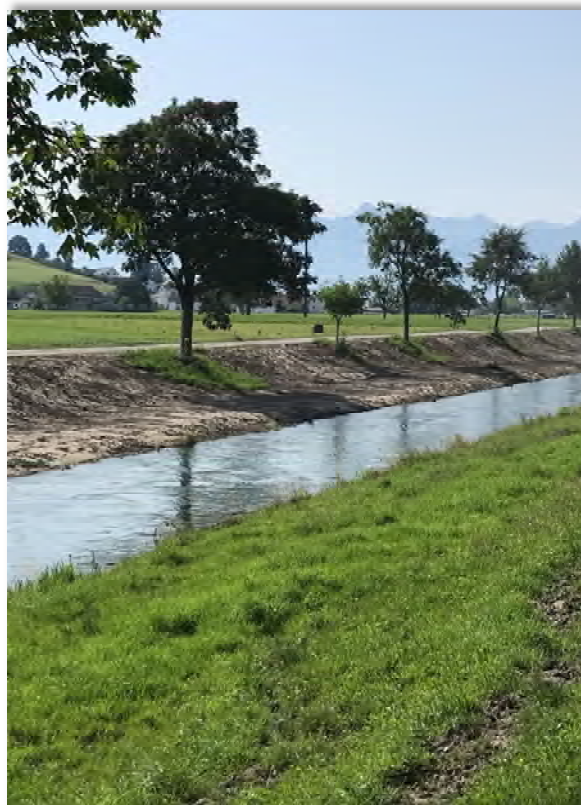
Lettenabtrag Baulos Kriessern
