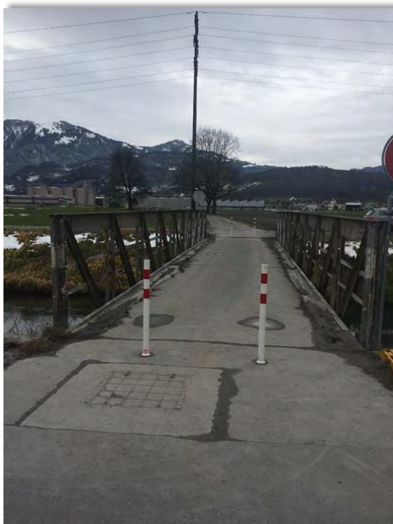
Oberriet km 16.38, Sperrung Bildstöcklibrücke
