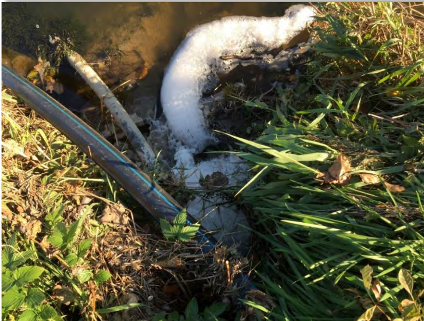
Kriessern km 11.25 links, Gewässerverunreinigung
