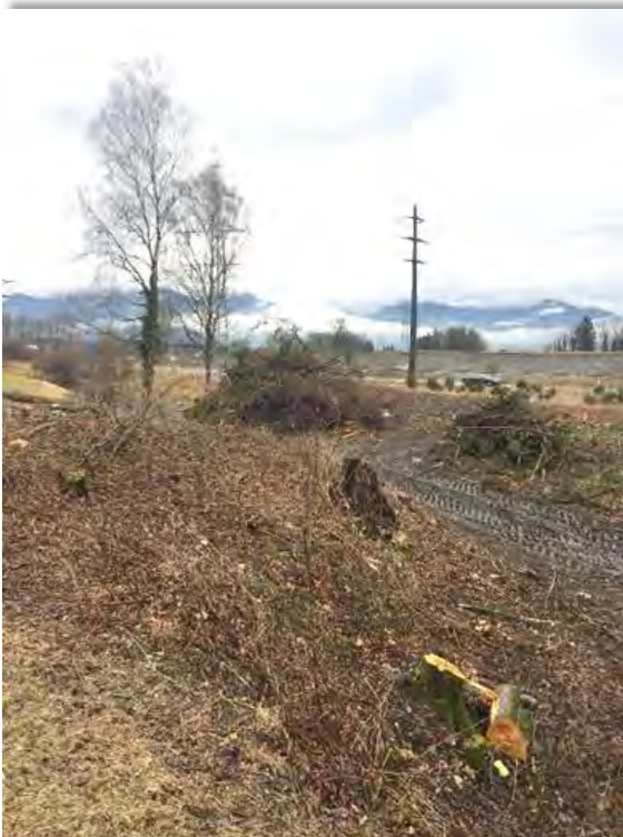
Rüthi km 18.8, Rodungsarbeiten entlang der SBB
