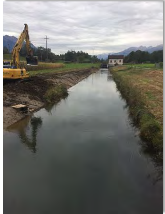
Lettenabtrag Lienz, km 23.0 rechts flussaufwärts
