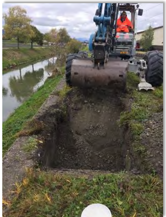
Au, km 2.5 - 2.6 links: Entnahme von Bodenproben und Baggerschlütze im Bereich der Stützmauer
