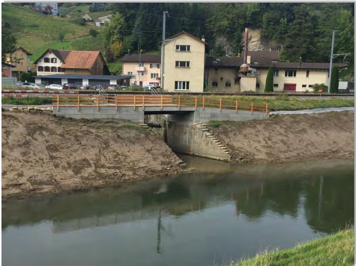
Au, km 2.1, neue Littenbachbrücke
