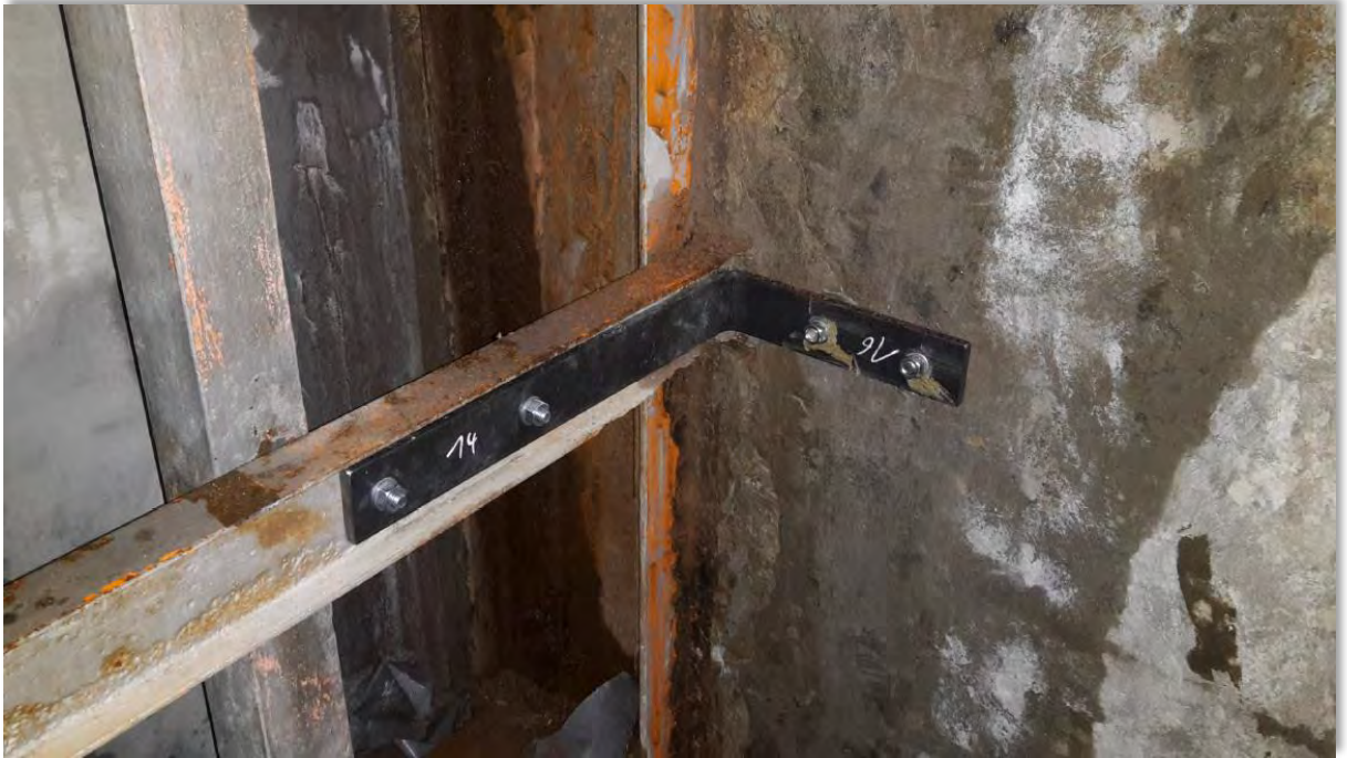
Lienz, km 23.65 Rillisdammschleuse, Reparatur und Ersatz Stahlwasserteile
