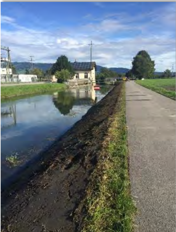
Lettenabtrag Montlingen, km 14.7 rechts
