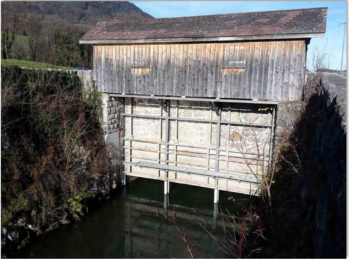
Lienz, km 23.65 Rillisdammschleuse, saniertes Bauwerk
