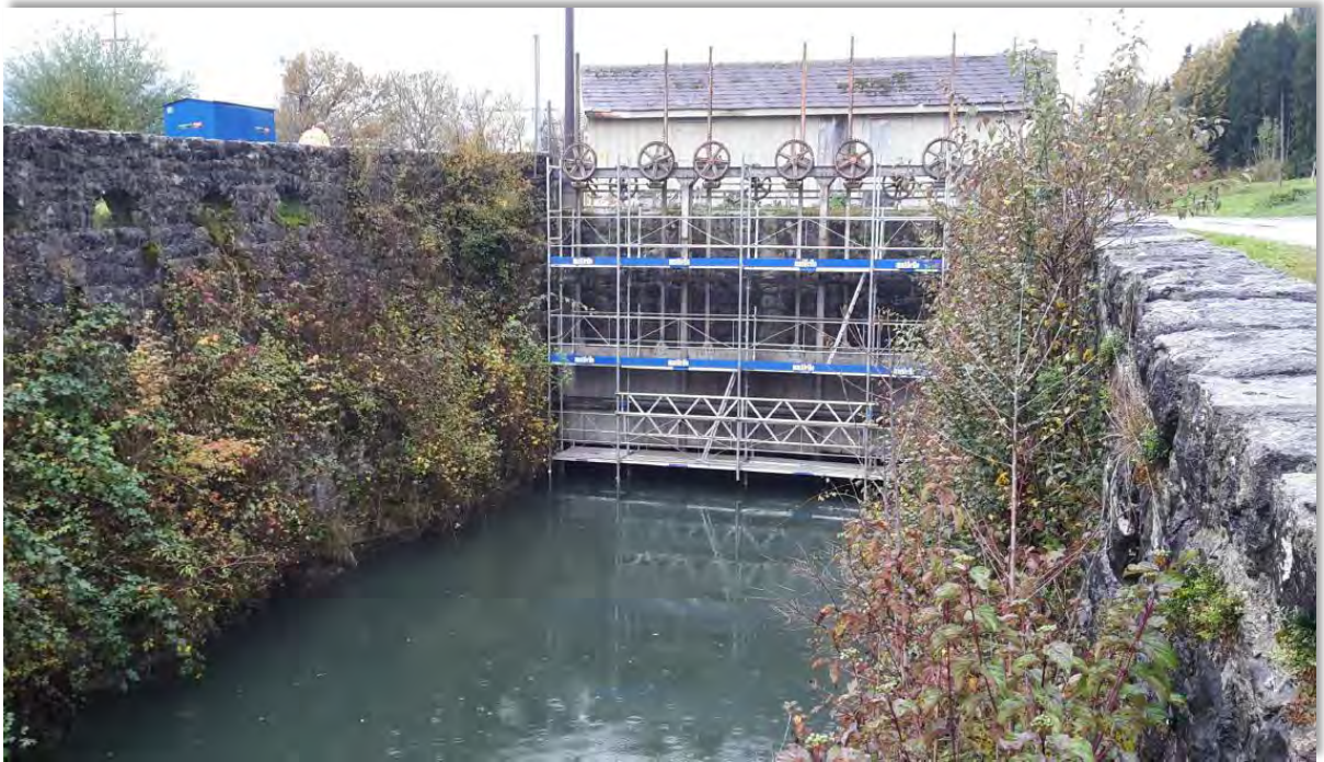
Lienz, km 23.65 Rillisdammschleuse, Baugerüst im Wasserlauf
