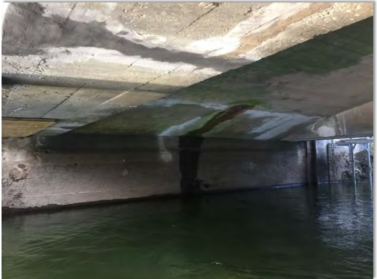
Lienz, km 23.65 Rillisdammschleuse, Reprofilierter und ausbetonierte Untersicht
