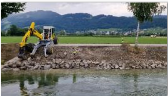
Erstellung Blockwurf zur Böschungsverstärkung
