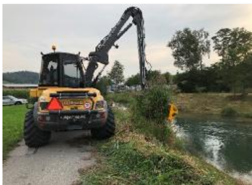
Mäharbeiten in Rüthi
