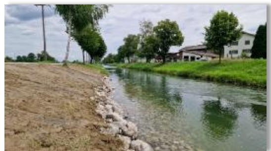
Fertige Böschung und neue Sohle
