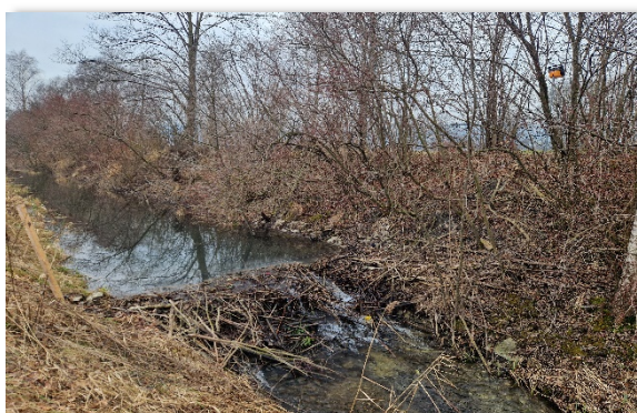
Biberdamm beim Baggersee, gesichert mit Draht, Kriessern
