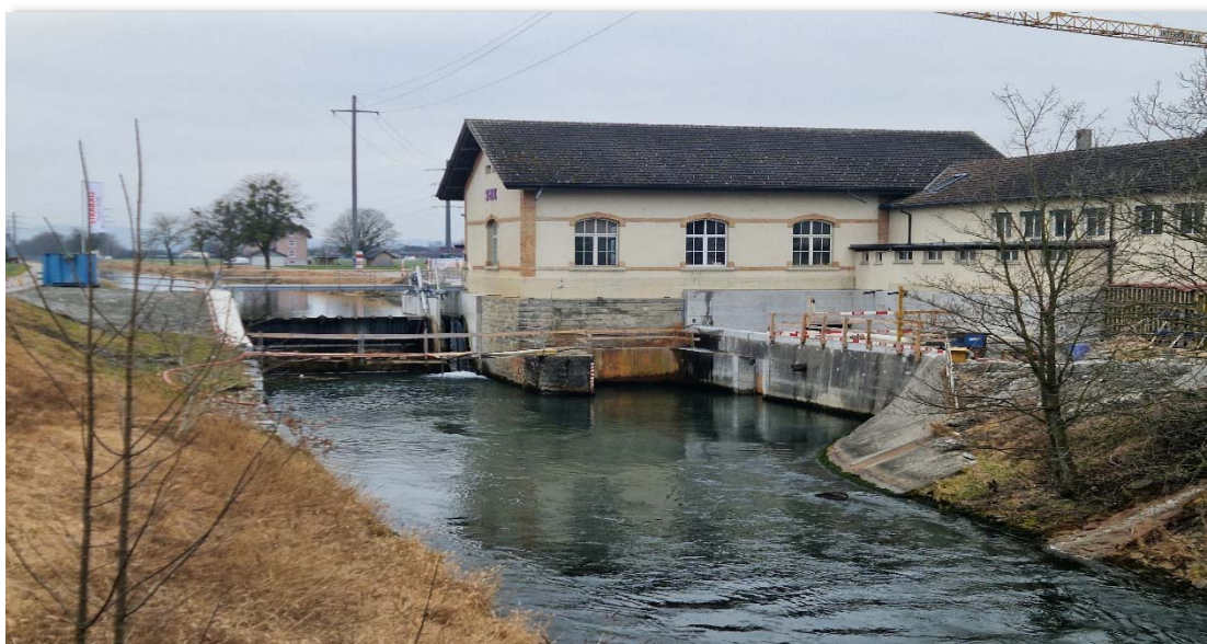
SAK Sanierung mit Fischtreppe in Montlingen
