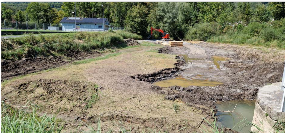
Entleerung Sedimentablagerungen, Steinebachsämmler, Sennwald
