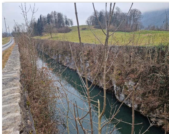
Bewuchs Rillisdammschleuse, Blick nach Süden, Lienz
