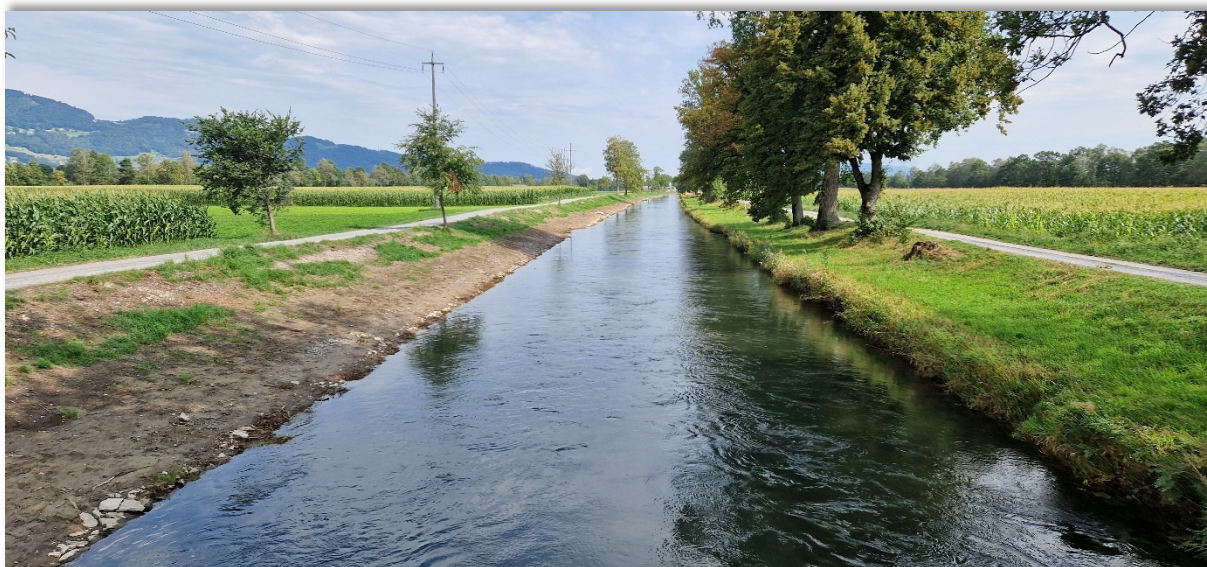
Lettenabtrag zehnte Etappe, linksseitiger und rechtsseitiger Abtrag
