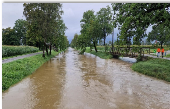
Blick Richtung Kriessern und Rietaach, Drei Brücken
