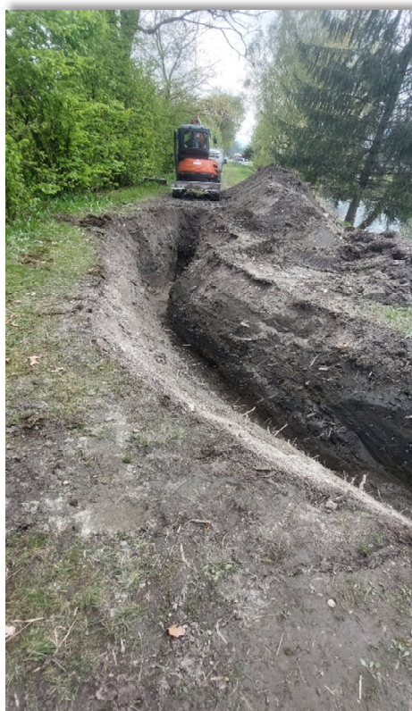
Die Tunnels müssen aufgegraben und im Anschluss wieder verfüllt werden
