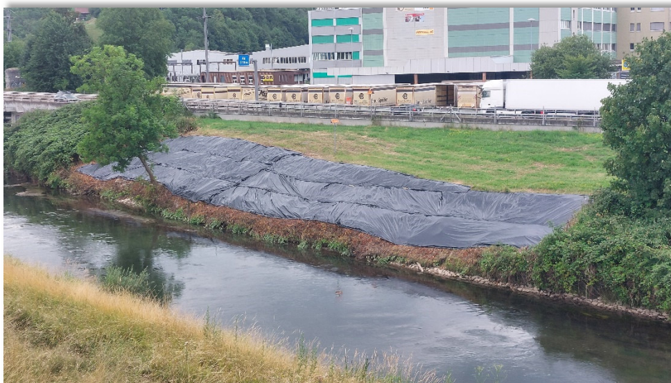
Der Knöterich wurde mit einer Plastikfolie abgedeckt um ihn zu schwächen
